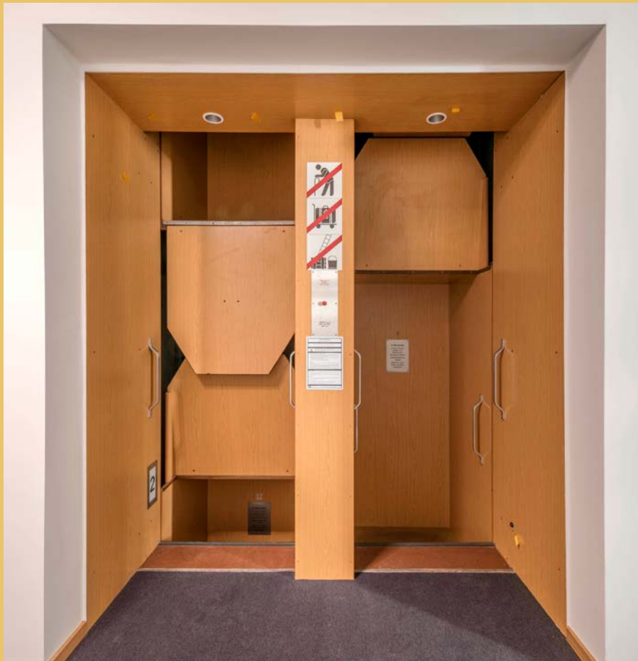
In der Kaiserzeit in vielen öffentlichen Verwaltungsgebäuden beliebt: der Paternoster. Das Exemplar in der Mauerstraße ist eines der letzten, das heute noch in Betrieb ist.
